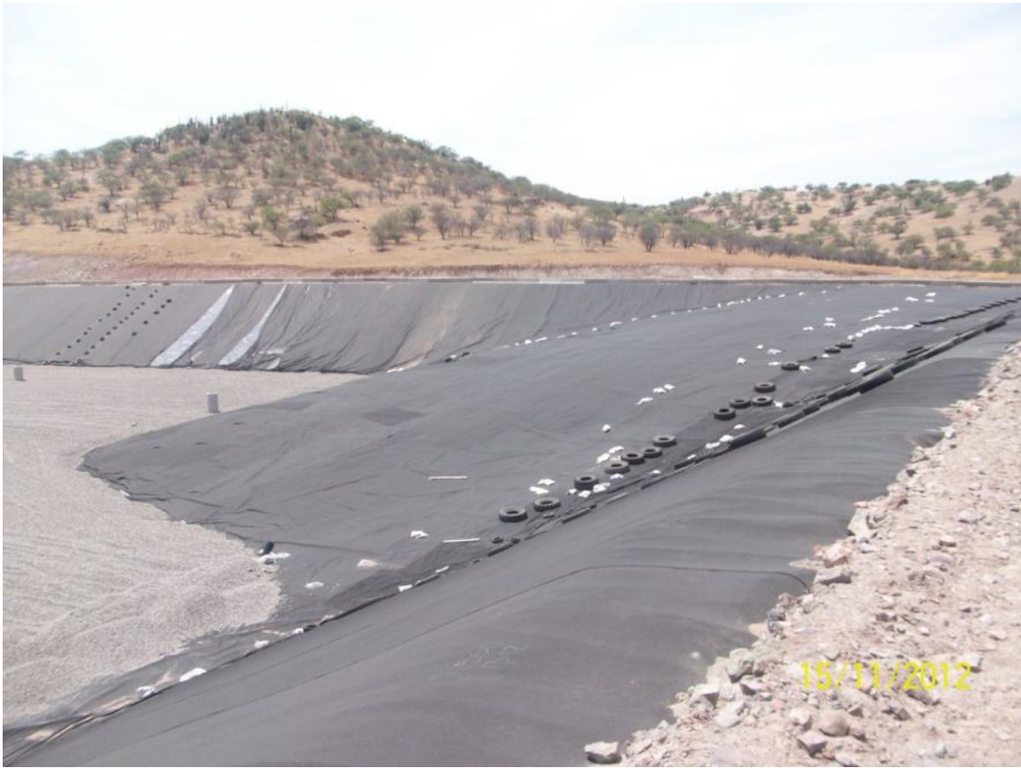
Foto 8: Vista vaso relleno sanitario Cerros la Leona.
