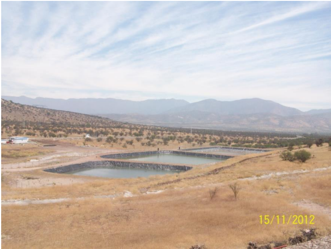
Foto 9: Vista piscinas de lixiviado relleno sanitario Cerros la Leona.
